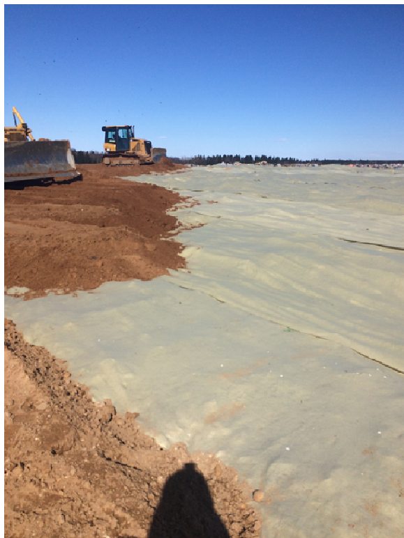
Рисунок 4 – Слой геотекстиля и грунта.
