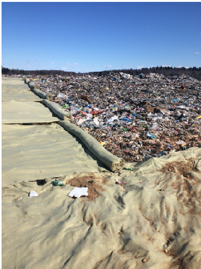
Рисунок 3 - Поверхность отходов, слой геотекстиля.
